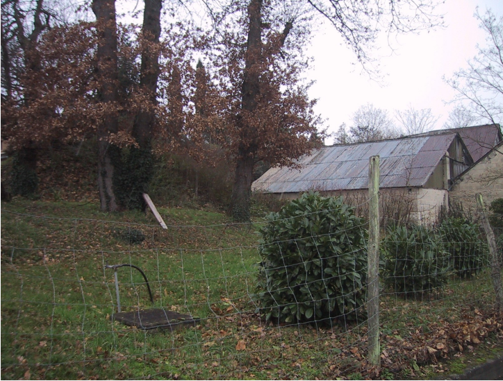
Les trois hangars qui abritaient la partie basse des fours
